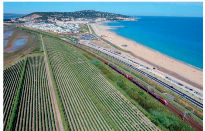
FIGURE 3.4. PHOTO PROTECTION ET AMÉNAGEMENT DURABLE DU LIDO DE SÈTE À MARSEILLAN (2003-2019)
