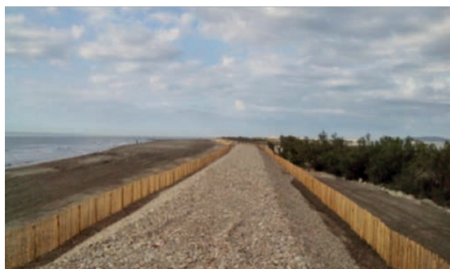
FIGURE 3.3. PHOTO SECTEUR ARESQUIERS APRÈS TRAVAUX
